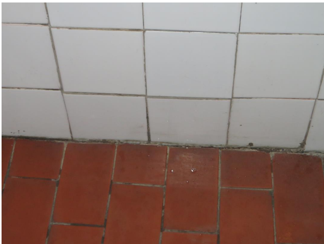
VANJSKI ZID SANITARNOG ČVORA
